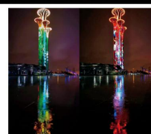
北京 奥运塔 照明控制项目
