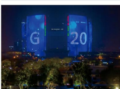
杭州G20 夜景亮化工程
