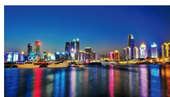
青岛 城市夜景亮化控制项目
