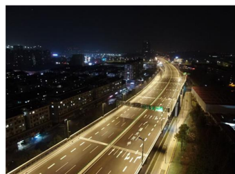
▲ 绍兴快速路项目
